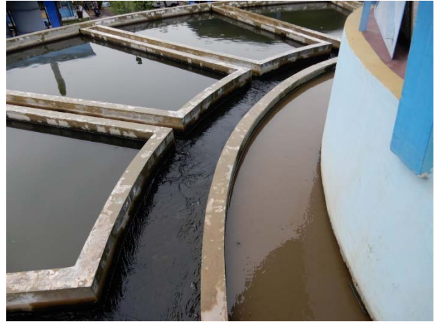
PDAM スラバヤの高速凝集沈殿池
