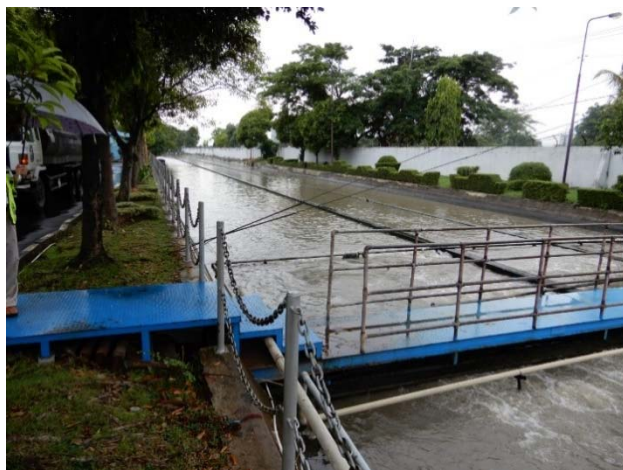
河川からの取水後の沈砂池
