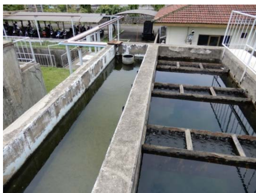
沈殿池(傾斜板を使用している)
