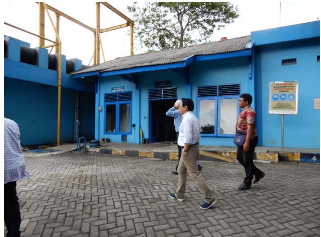
配水池事務所（管理人常駐）
