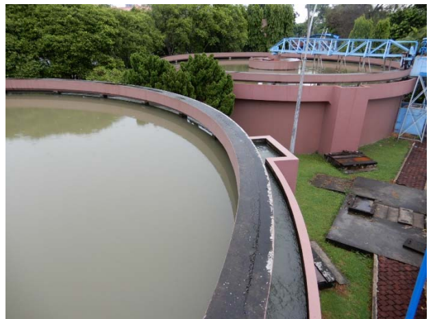
高速凝集沈殿池の排水の濃縮槽
