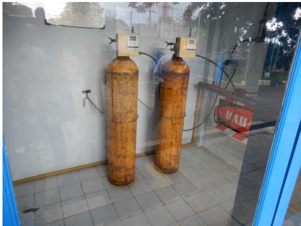
塩素ガスを使用（配水池にて）
