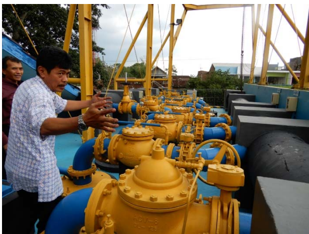
配水池屋上のポンプ設備（ここは配水池というよりポンプ井）
