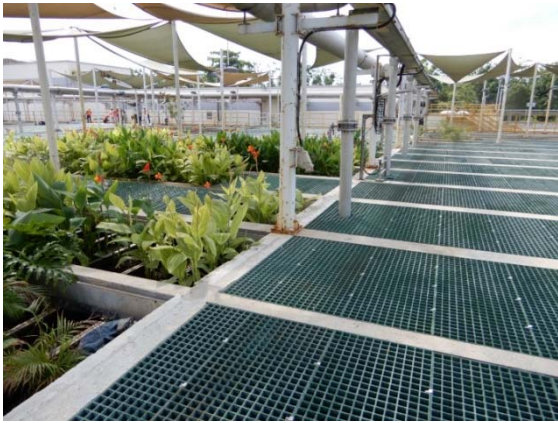
MM2100 の浄水沈殿池（傾斜板を使用）
