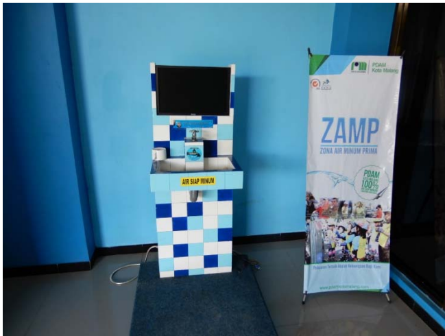
給水栓は良好（残塩：0.6ppm、COD 2 ppm を検出）
