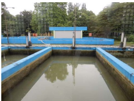
急速濾過池：黄色く濁っている
