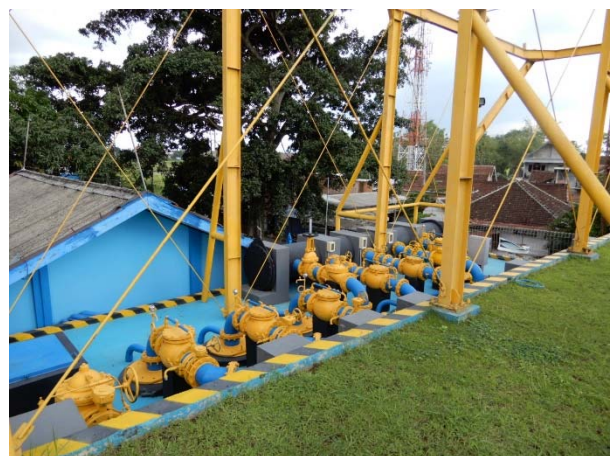
配水池の屋上からポンプ設備を見る
