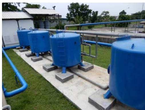
鋼板製の急速ろ過装置
