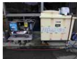
刻々と変わる被災地の要求に対応する万能浄水機として稼働しました。
